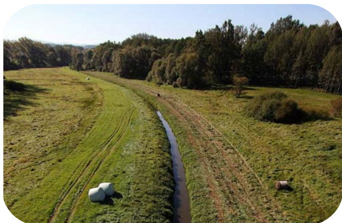
Stav koryta řeky Stropnice v důsledku regulací prováděných v osmdesátých letech 20. století.
