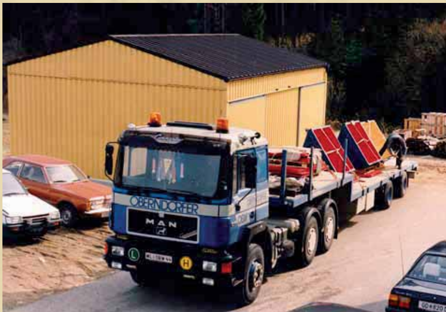
Die „Sandstrahl-Halle“, die neben dem Produktionsgebäude von 1989 errichtet wurde. Davor der LKW eines Beton-Fertigteile-Herstellers bei der Abholung von neu beschichteten Materialtrichtern einer Beton-Mischanlage. Foto: ASMA
