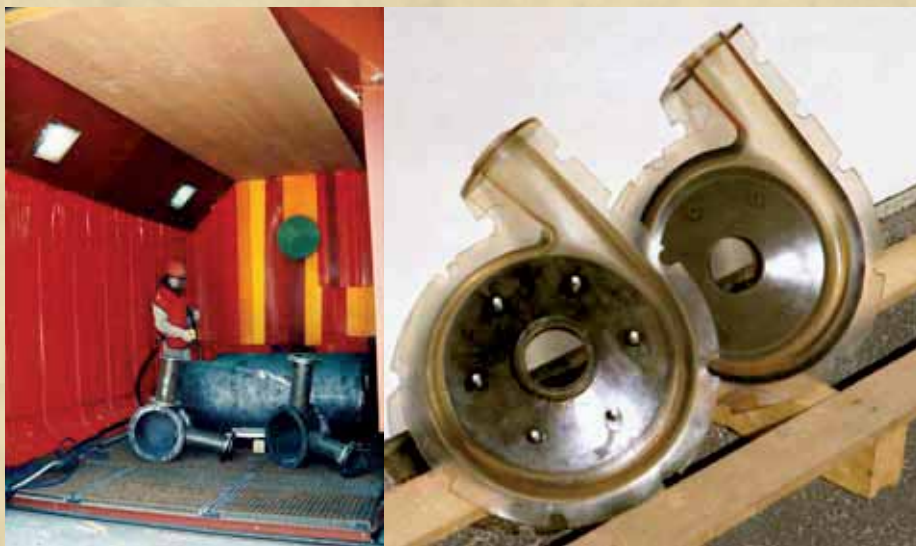
Sandstrahlen von Großformteilen vor der PU-Beschichtung. Daneben ein Beispiel eines PU-Pumpengehäuses. Foto: ASMA
