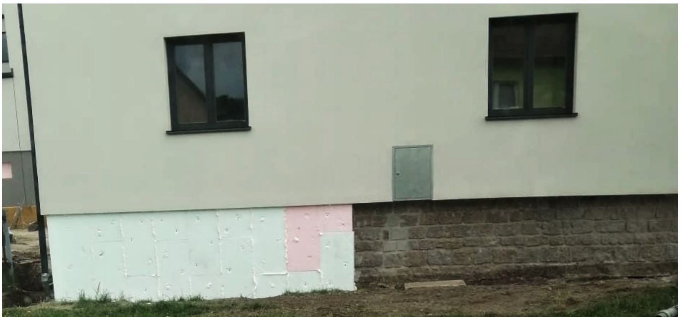
Abbildung 2: Natursteinsockel des Gemeindeamts mit Styroporplatten beklebt
