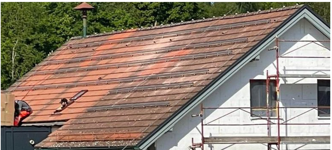
Abbildung 1: Montage der neuen PV-Anlage am Dach des Gemeindeamtes
